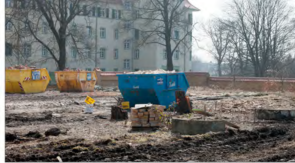
Noch sieht es hier nach Baustelle aus
