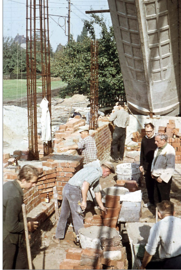
Mauerarbeiten an der Giebelwand neben des Eingangs, wo Friedrich Press (rechts) die Skulptur des in Jerusalem einziehenden Christus gestalten wird, das Titelbild dieses Georgsboten
